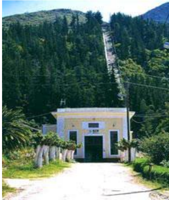
Εικ.12.1 Ο πρώτος υδροηλεκτρικός σταθμός στην Ελλάδα, στη περιοχή και με τα νερά του ποταμού Γλαύκου. Στη φωτογραφία διακρίνεται ο κάθετος αγωγός που φέρνει με ορμή το νερό από την κορυφή του λόφου στις ηλεκτρογεννήτριες 8
