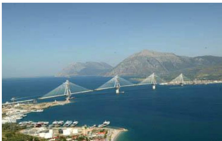
ΡΙΟ - ΑΝΤΙΡΡΙΟ, ΚΑΤΑΣΚΕΥΗ ΓΕΦΥΡΑΣ ΜΑΪ '04
