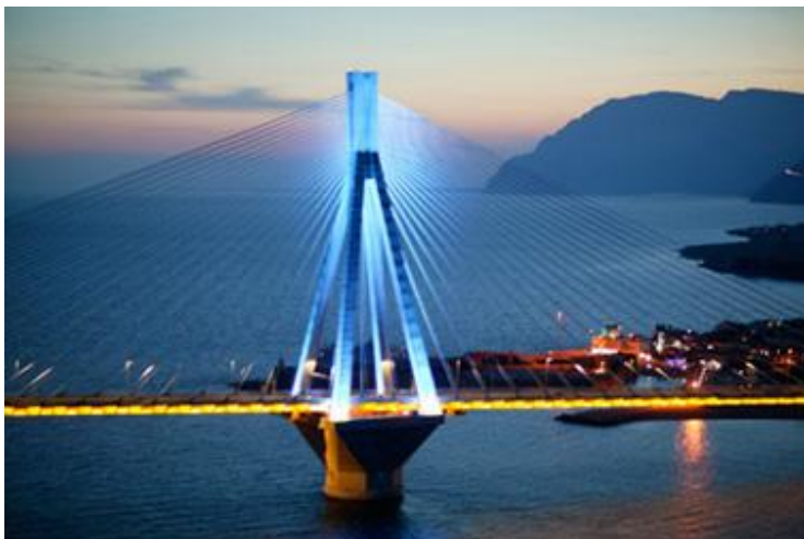
ΡΙΟ - ΑΝΤΙΡΡΙΟ, ΚΑΤΑΣΚΕΥΗ ΓΕΦΥΡΑΣ ΑΥΓ '04
