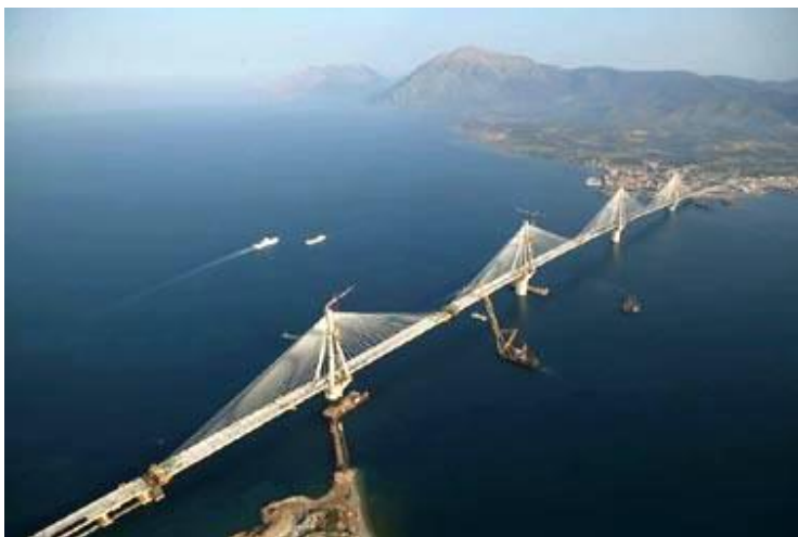
ΡΙΟ - ΑΝΤΙΡΡΙΟ, ΚΑΤΑΣΚΕΥΗ ΓΕΦΥΡΑΣ ΜΑΪ '04
