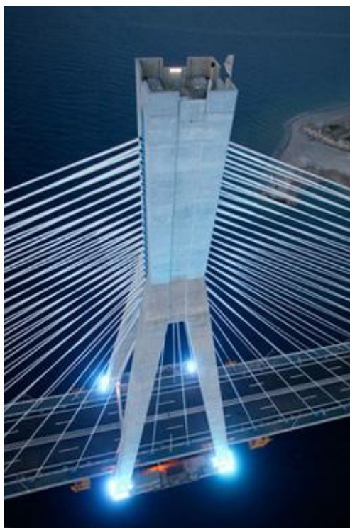
ΡΙΟ - ΑΝΤΙΡΡΙΟ, ΚΑΤΑΣΚΕΥΗ ΓΕΦΥΡΑΣ ΑΥΓ '04
