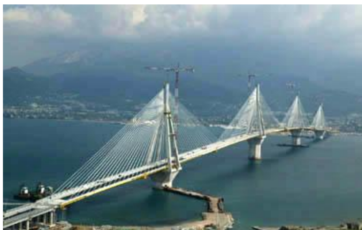
ΡΙΟ - ΑΝΤΙΡΡΙΟ, ΚΑΤΑΣΚΕΥΗ ΓΕΦΥΡΑΣ ΑΠΡ '04
