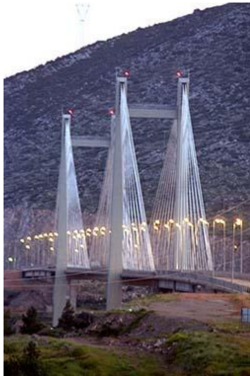
ΓΕΦΥΡΑ ΧΑΛΚΙΔΑΣ ΙΟΥΝ '93
