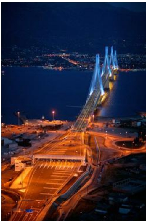
ΡΙΟ - ΑΝΤΙΡΡΙΟ, ΚΑΤΑΣΚΕΥΗ ΓΕΦΥΡΑΣ ΑΥΓ '04
