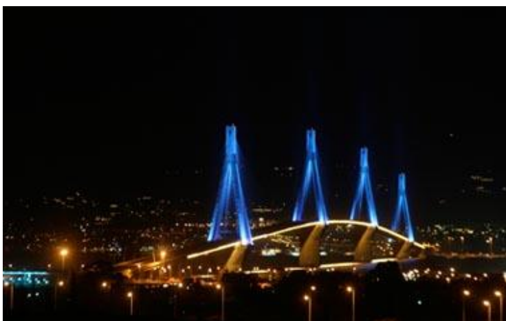
ΡΙΟ - ΑΝΤΙΡΡΙΟ, ΚΑΤΑΣΚΕΥΗ ΓΕΦΥΡΑΣ ΑΥΓ '04
