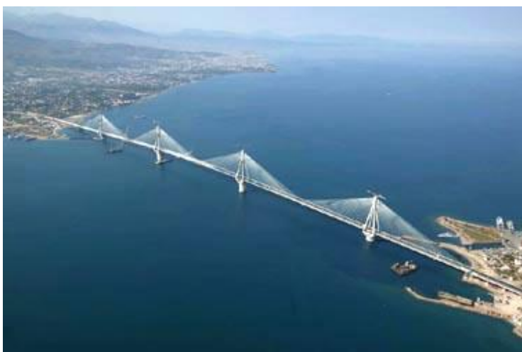
ΡΙΟ - ΑΝΤΙΡΡΙΟ, ΚΑΤΑΣΚΕΥΗ ΓΕΦΥΡΑΣ ΜΑΪ '04
