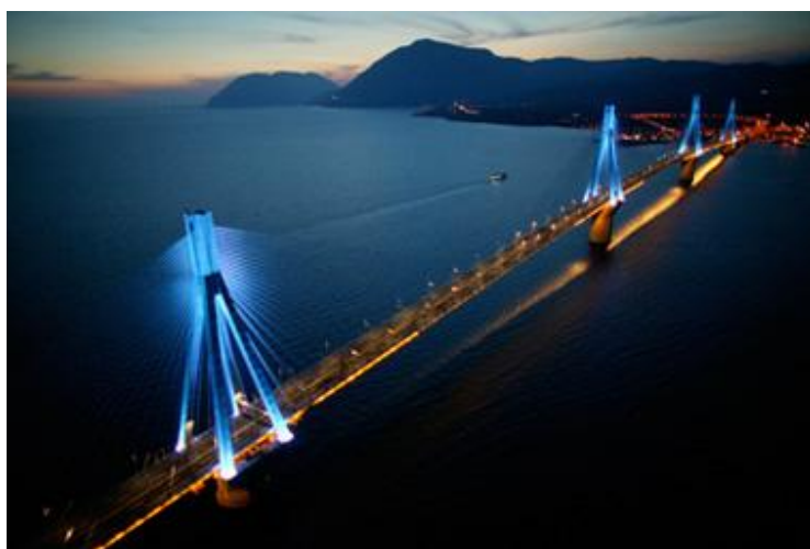
ΡΙΟ - ΑΝΤΙΡΡΙΟ, ΚΑΤΑΣΚΕΥΗ ΓΕΦΥΡΑΣ ΑΥΓ '04
