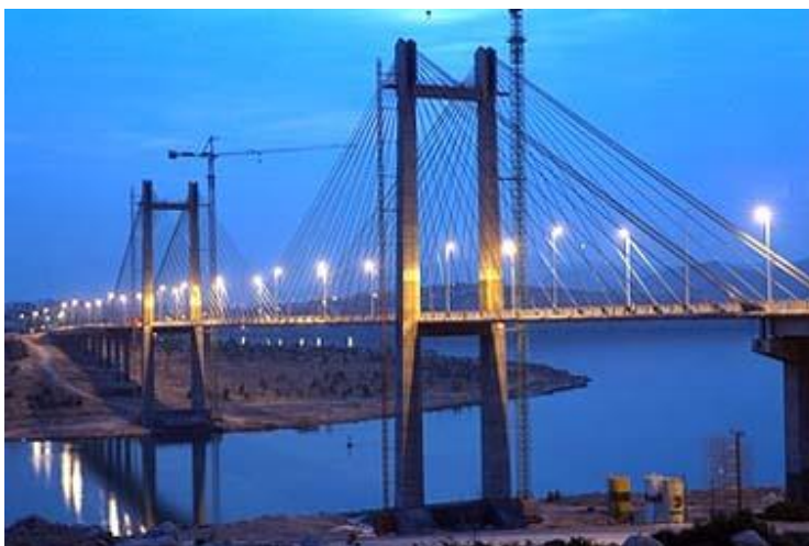
ΓΕΦΥΡΑ ΧΑΛΚΙΔΑΣ ΙΟΥΝ '93
