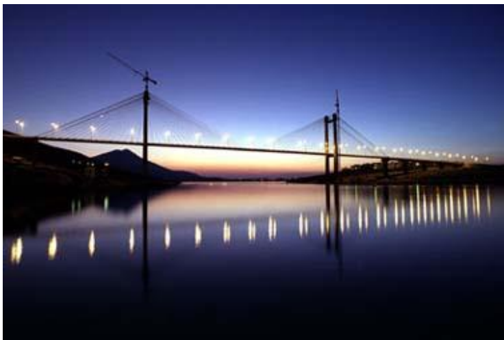
ΓΕΦΥΡΑ ΧΑΛΚΙΔΑΣ ΙΟΥΝ '93
