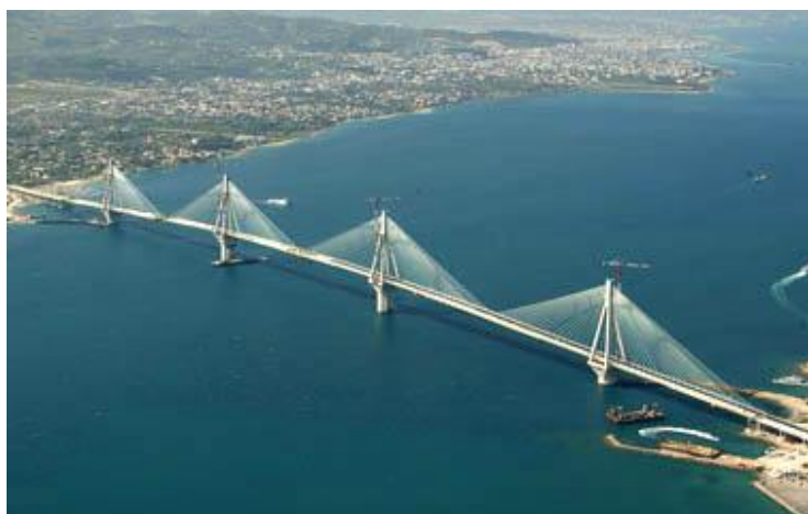
ΡΙΟ - ΑΝΤΙΡΡΙΟ, ΚΑΤΑΣΚΕΥΗ ΓΕΦΥΡΑΣ ΜΑΪ '04
