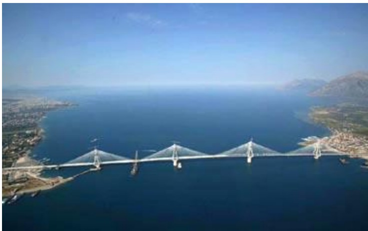
ΡΙΟ - ΑΝΤΙΡΡΙΟ, ΚΑΤΑΣΚΕΥΗ ΓΕΦΥΡΑΣ ΜΑΪ '04
