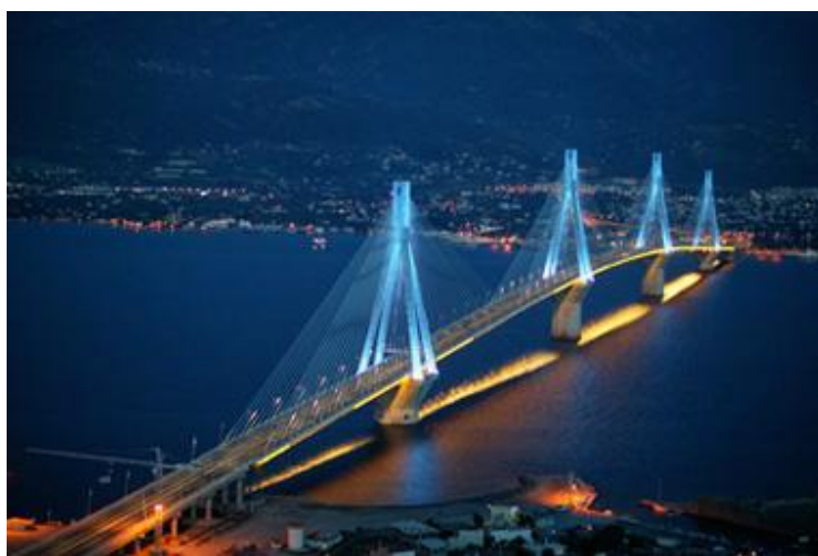
ΡΙΟ - ΑΝΤΙΡΡΙΟ, ΚΑΤΑΣΚΕΥΗ ΓΕΦΥΡΑΣ ΑΥΓ '04
