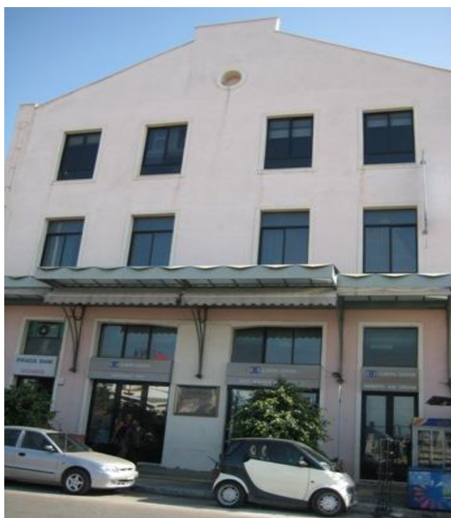
Φωτ. 30. Πρώην σταφιδαποθήκη Αντωνόπουλου επί της οδού Όθ. Αμαλίας
