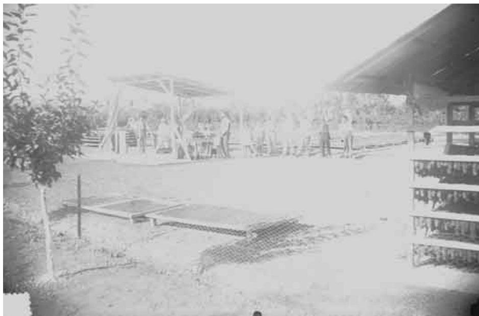
Φωτ. 5.21. Αλώνι: Τοποθέτηση τζιβιερών στο αλώνι
