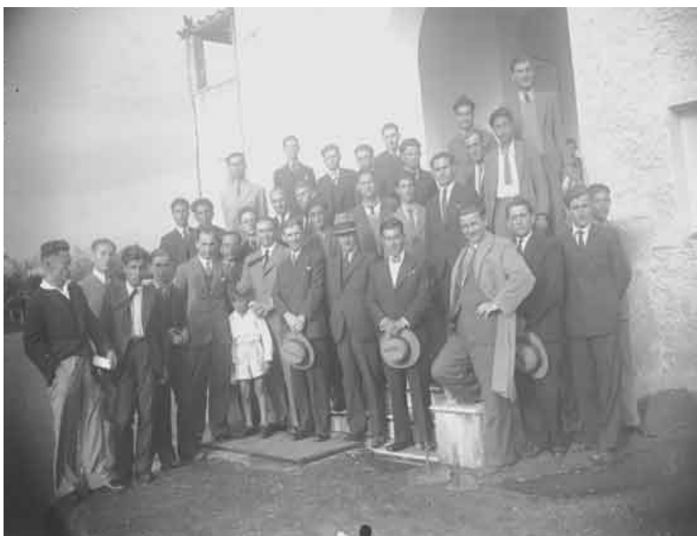
Φωτ. 2.9. Αίγιο, Σύλλογος Μεταφορέων Σταφίδας
