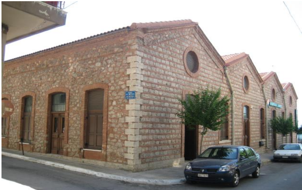
Φωτ. 28. Πρώην σταφιδαποθήκη Πετρά επί της οδού Όθ. Αμαλίας (άποψη)
