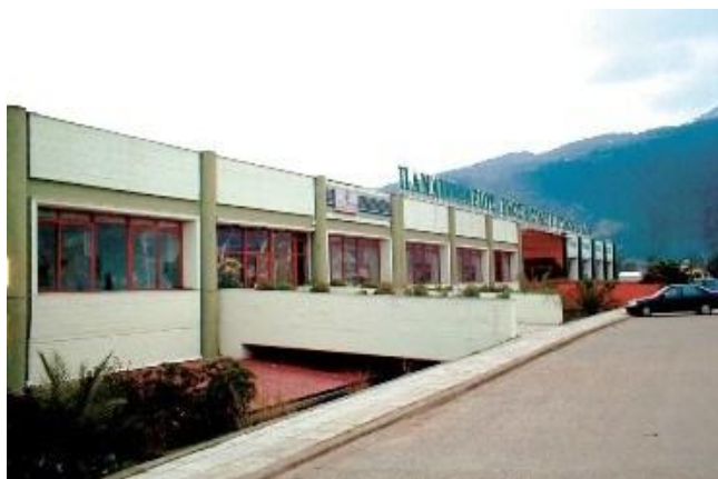
Φωτ. 6.4. Εξωτερική άποψη Π.Ε.Σ.
