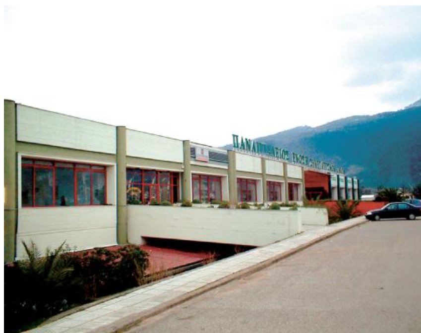
Φωτ. 9.2. Εξωτερική άποψη Π.Ε.Σ.
