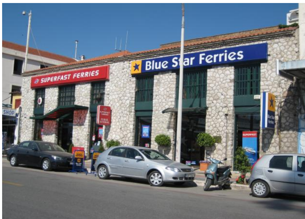
Φωτ. 26. Πρόην σταφιδαποθήκη Παρθενόπουλου επί της οδού Όθ. Αμαλίας
