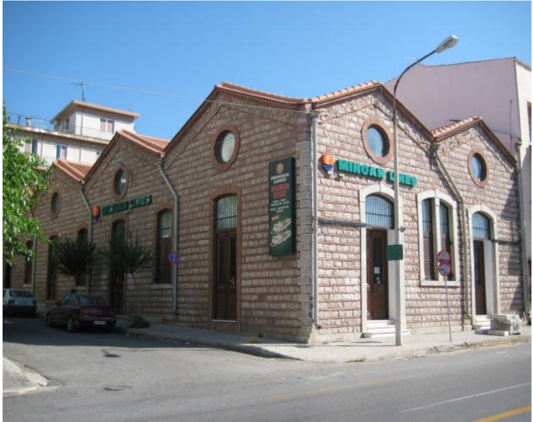
Φωτ. 27. Πρώην σταφιδαποθήκη Πετρά επί της οδού Όθ. Αμαλίας
