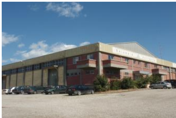
Φωτ. 6.7. Εξωτερική άποψη, Μπελούσης Α.Ε.
