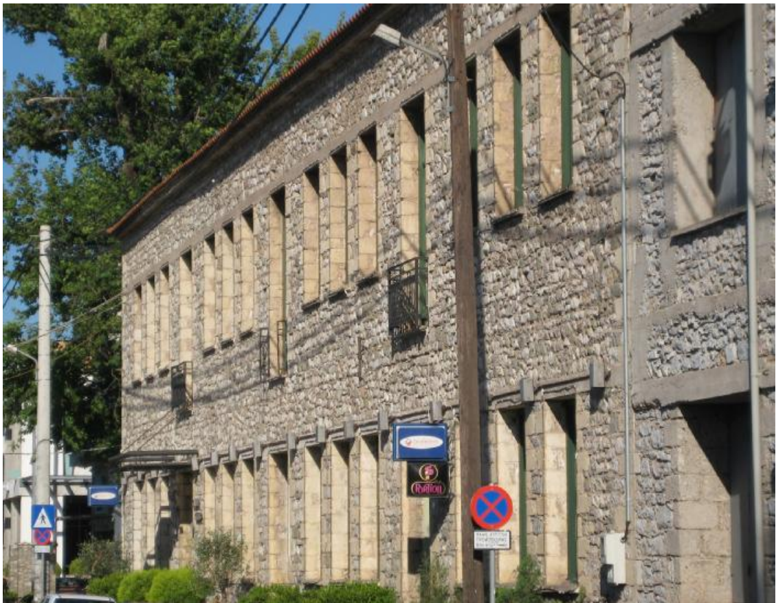
Φωτ. 12. Πρώην Σταφιδαποθήκη του Συνεταιρισμού Ανδραγούστης
