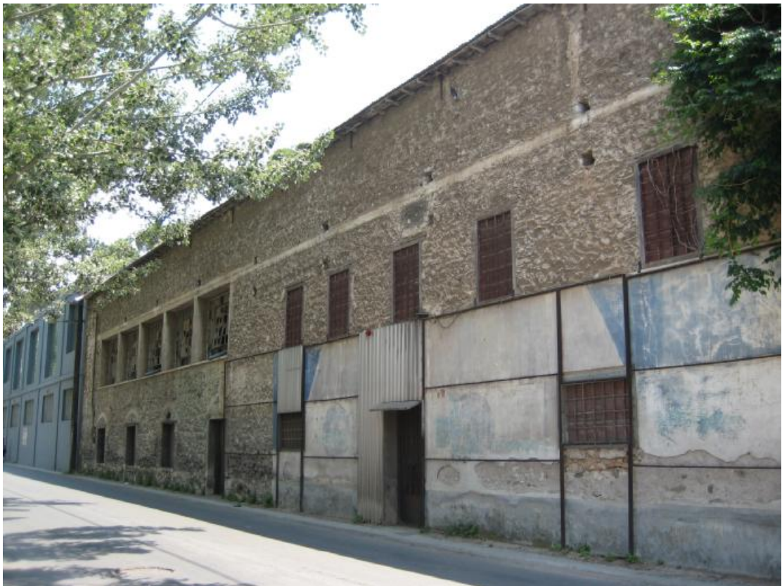
Φωτ. 3. Διασωζόμενη σταφιδαποθήκη Αιγίου στην οδό Ζωοδόχου Πηγής.
