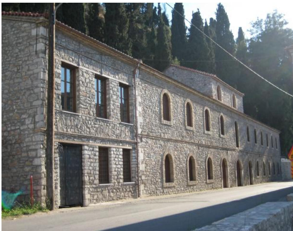
Φωτ. 9. Το κτίριο της σταφίδαποθήκης του Ευθυμίου Γάτου στη οδό Ζωοδόχου Πηγής, δίπλα στην Τρυπητή
