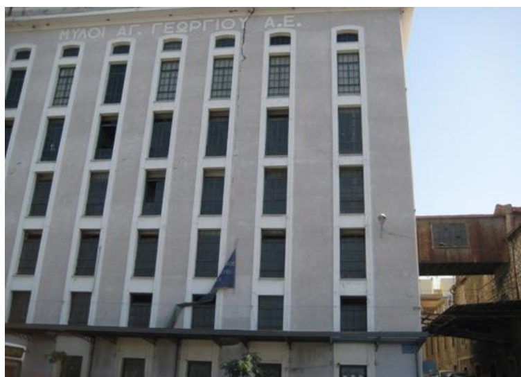
Φωτ. 29. Πρώην σταφιδαποθήκη Τριάντη επί της οδού Όθ. Αμαλίας
