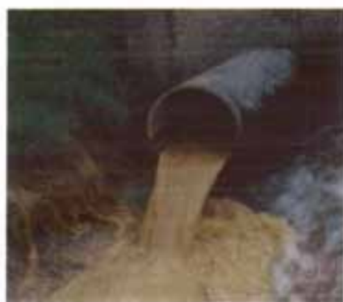
Αποχέτευση που οδηγεί στη θάλασσα
