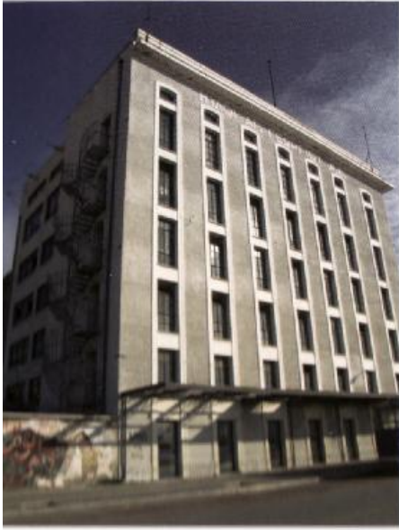
Εικ.1.Σημερινή άποψη των Μύλων από την οδό Όθωνος Αμαλίας.(Πηγή: Βιομηχανικά Κτίρια της Δ.Ελλάδος ΚΕΤΑ-ΔΕ Φωτόγ. Ν.Ψαθογιαννάκης&Β.Πέττας)
