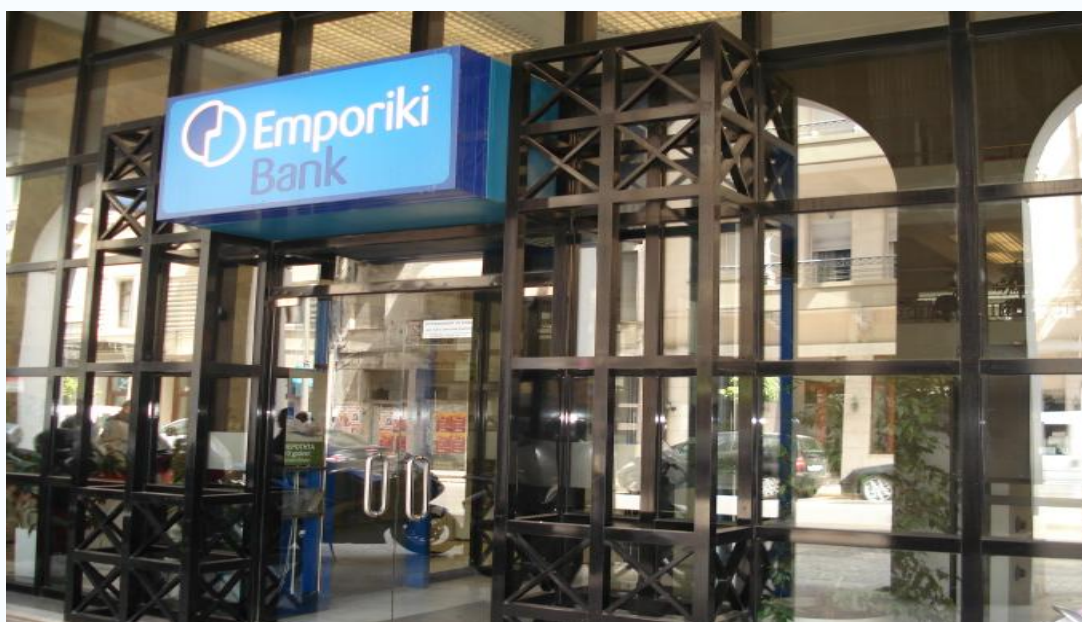
Κατάστημα στην οδό Αγ. Ανδρέου 53, Πάτρα
