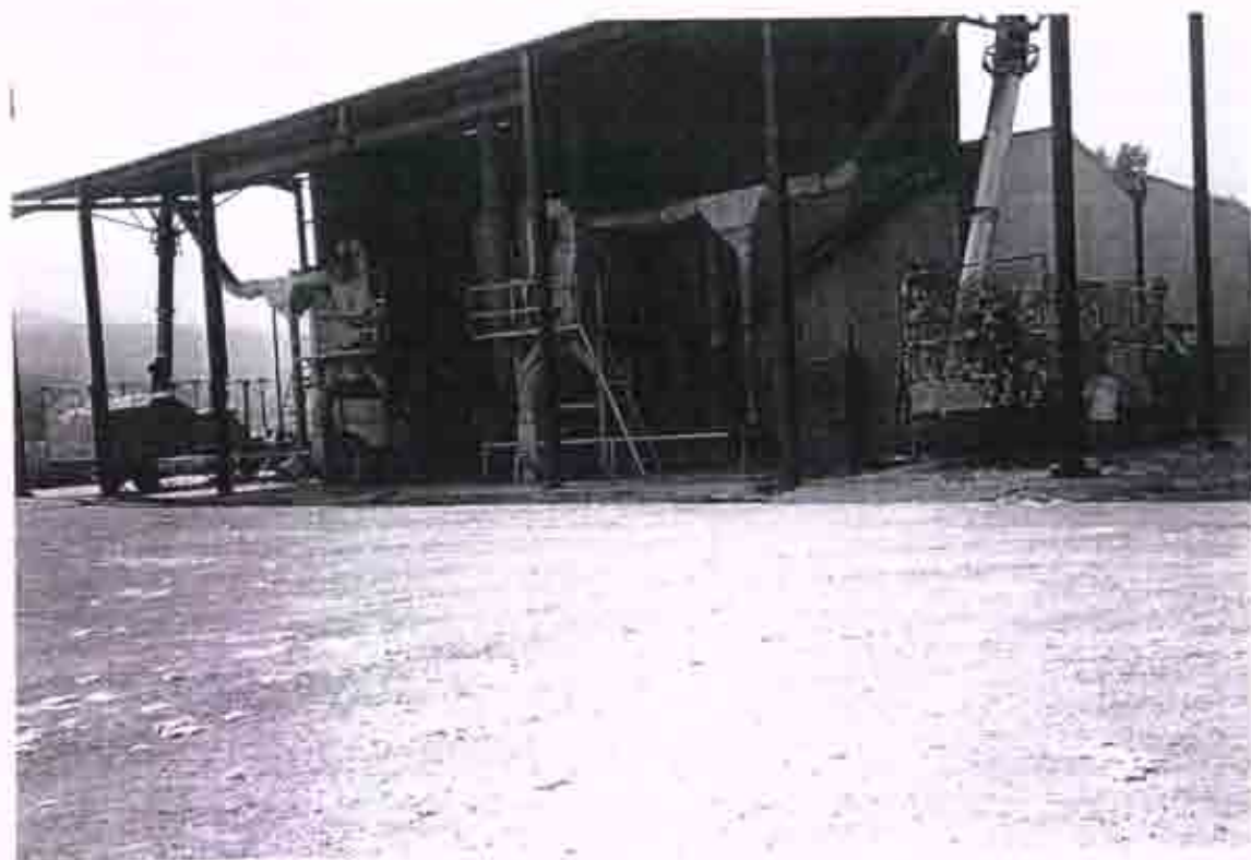
Εικ. 12. Τμήμα των εγκαταστάσεων εκκ/ρίου (ξηραντήριο).
