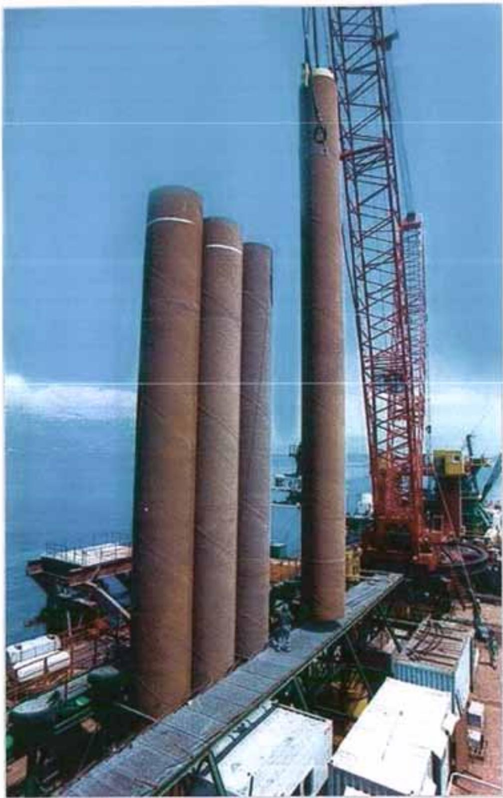
Στη θάλασσα: τοποθέτηση των πασσάλων θεμελίωσης
