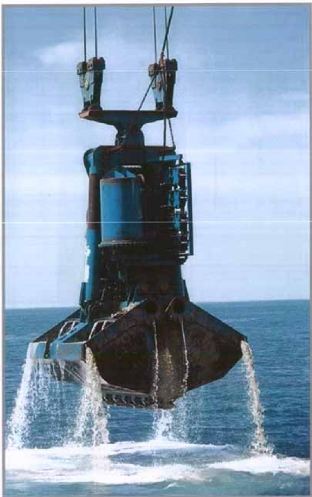
Βιθοκόρηση 20 κυβικών μέτρων στη θέση του βάθρου M3
