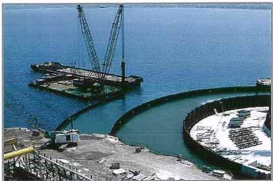
Απομάκρυνση των πασσαλοσανίδων του αναχώματος έμφραξης
