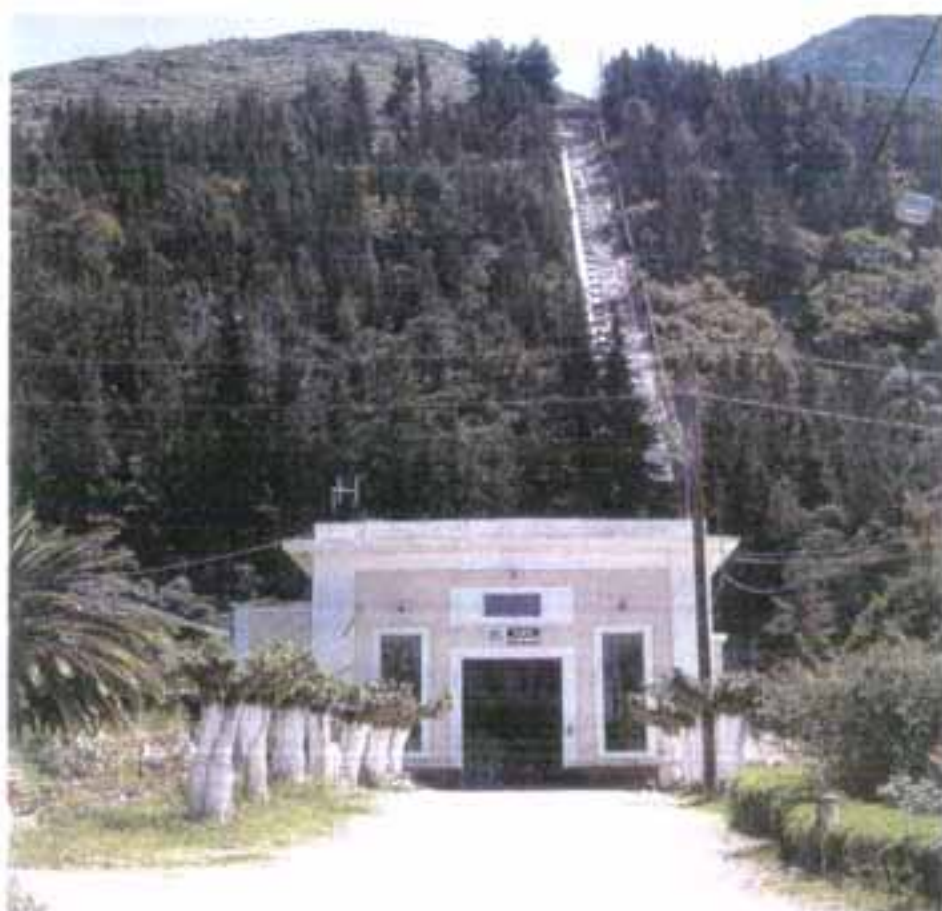
Υδροηλεκτρικό εργοστάσιο «Γλαύκος»
