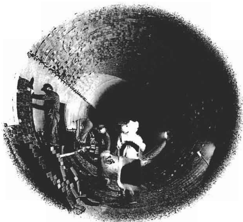
Εργοστάσιο Καμαρίου: Εργασίες συντήρησης στο εσωτερικό περιστροφικού κλιβάνου
