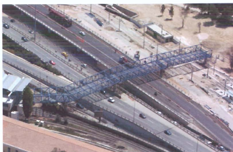
πεζογέφυρα στην περιοχή του Φαλήρου
