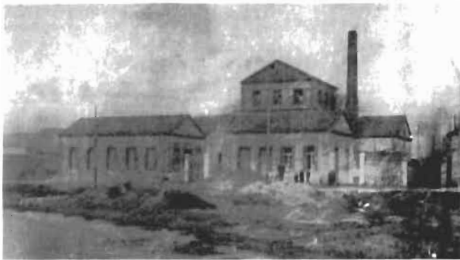
Γενική άποψη του εργοστασίου που κτίστηκε από τον Ν. Ασημακόπουλο (1870-1900 περίοδος)
