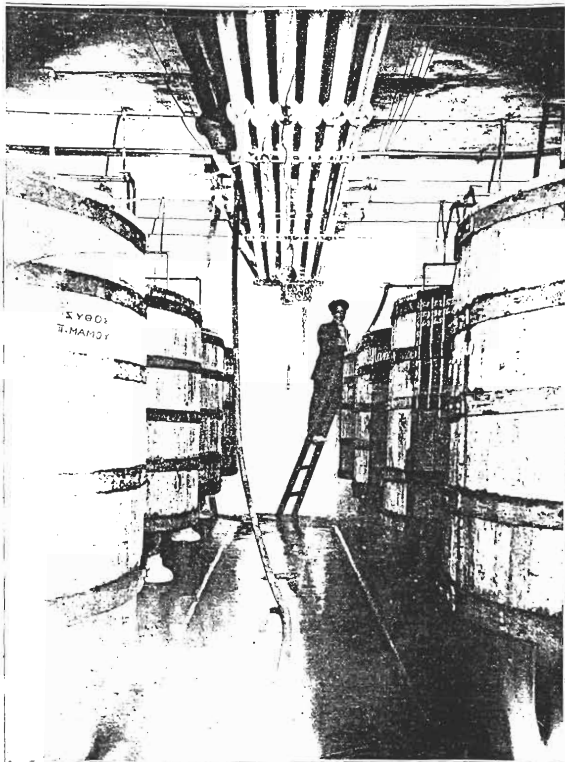
Τμήμα αποθήκης ζιμωτηρίου. Μεγάλοι κάδοι των 2.500 σκάδων από ξύλο δρυός
