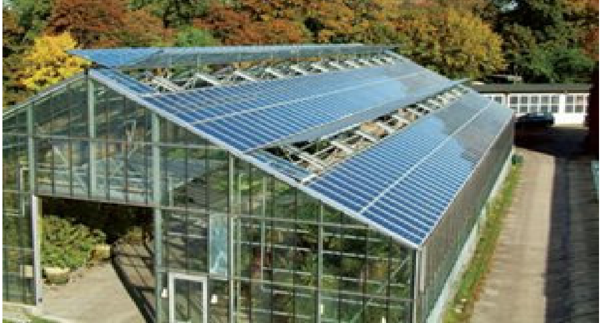
Εικόνα 3.2: Φωτοβολταϊκά πλαίσια τοποθετημένα επί της οροφής θερμοκηπίου
