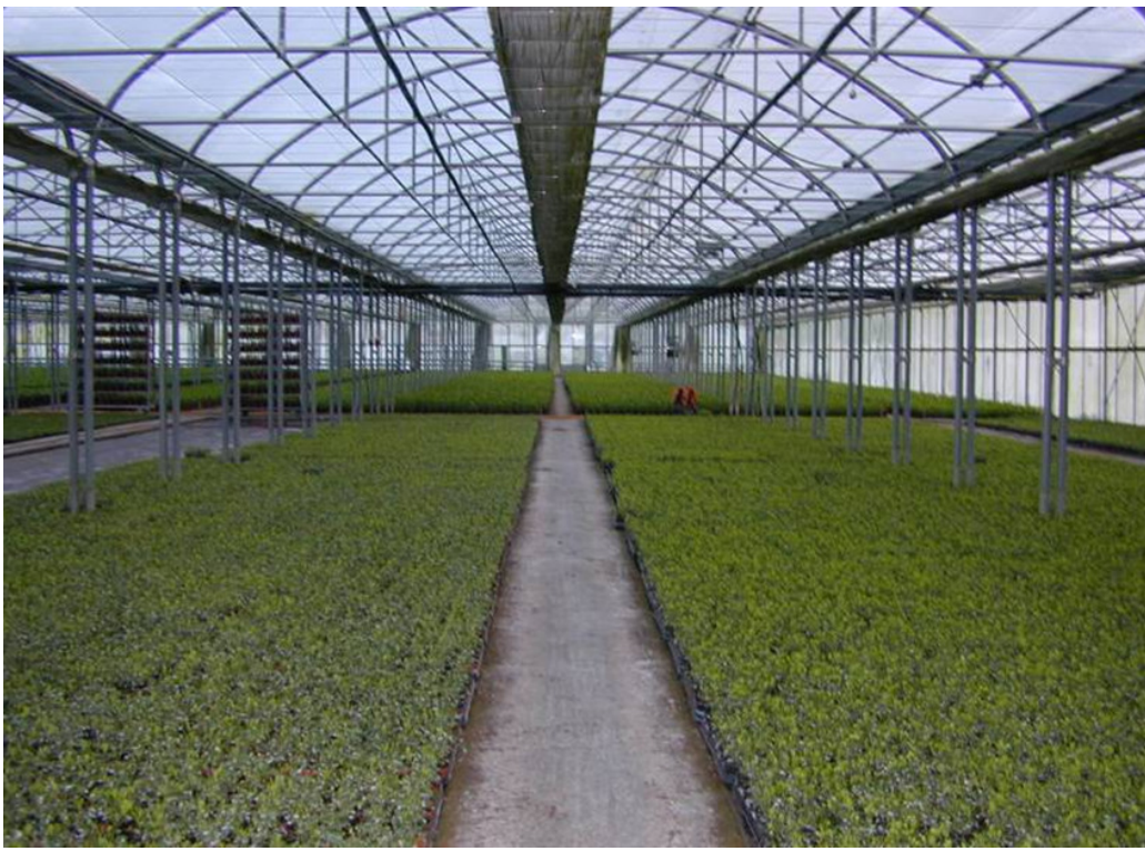
Εικόνα 15: Επιδαπέδια Θέρμανση θερμοκηπίου με βιομάζα (πυρηνόξυλο)
