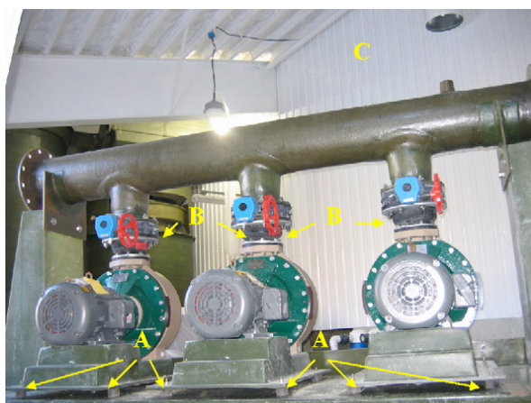
Εικόνα 9: Μείωση της μετάδοσης των δονήσεων και του θορύβου με στήριξη σε ελαστικά παρεμβύσματα (Βέλη Α)
