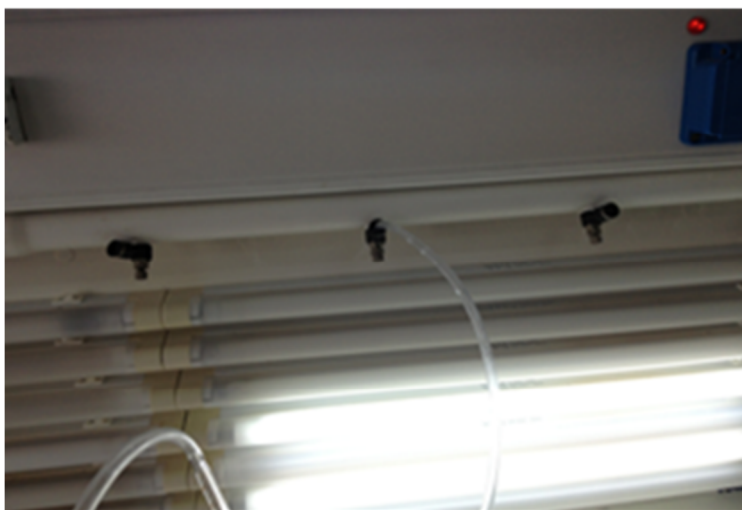
Εικόνα 8: Δίκτυο αερισμού με βανάκια φικς για τη ρύθμιση της παροχής αέρα στις καλλιέργειες
