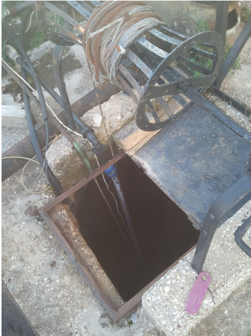
(3.6) Πηγάδι με υποβρύχιο τύπο αντλίας
