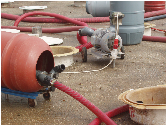
(Φώτο 6) Απεικονίζονται οι αντλίες που δίνουν νερό και τραβάνε νερό από τις δεξαμενές.
