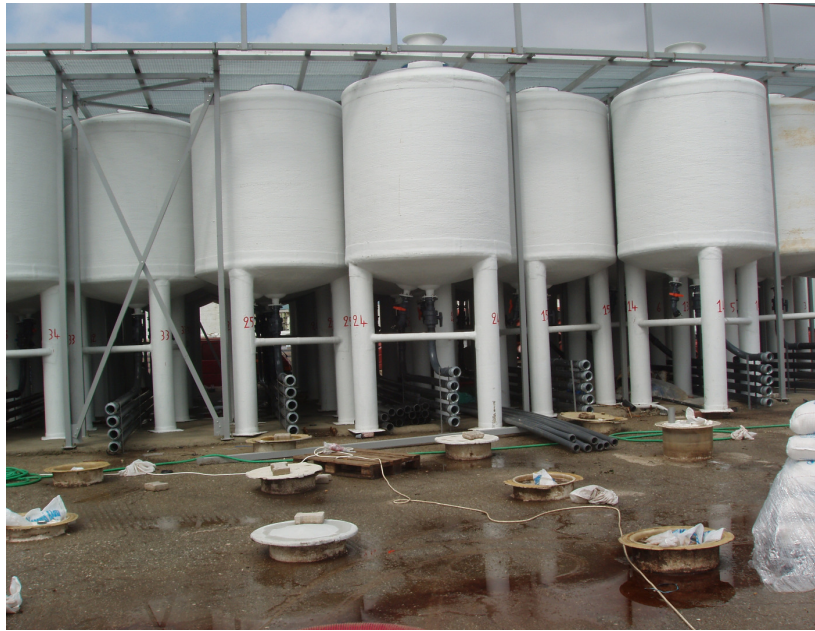
(Φώτο. 1) Υπέργειες δεξαμενές για αποθήκευση ελιών.
