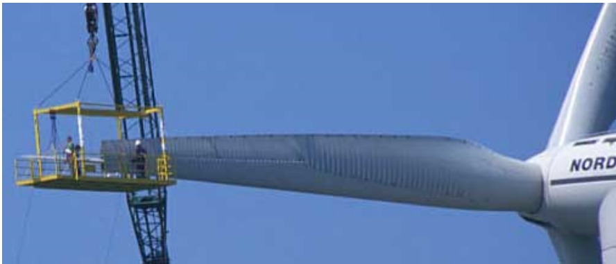
Σχήμα 8.5: Ομάδα εργατών που ασχολούνται με τη συντήρηση και επισκευή δρομέα με διάμετρο 32 m, μιας μηχανής 1,5 MW.
