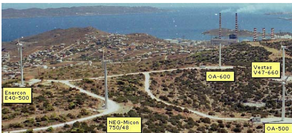
( φωτογραφία από τον 100μ μετεωρολογικό ιστό, ΒΒΔ του Α/Π, πριν την εγκατάσταση της ατράκτου της OA-600 )
