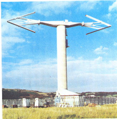
Ανεμογεννήτρια κατακόρυφου άξονα, αετιόμορφος σχήματος πύργου, ύψους 125m.
