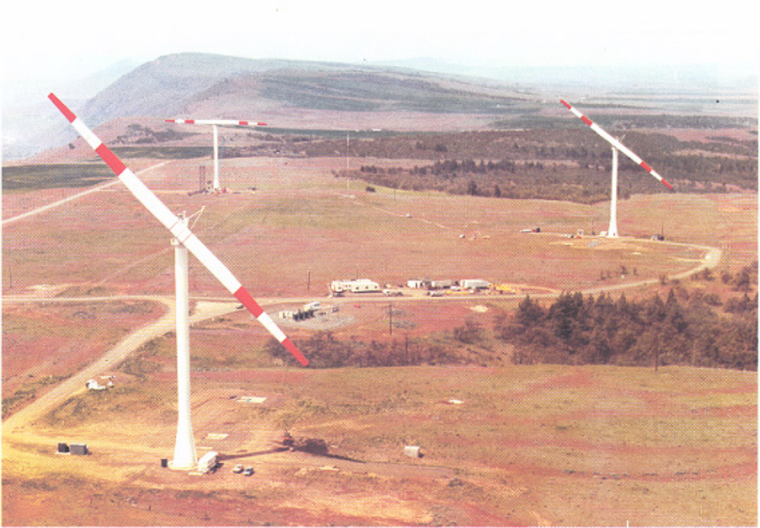
Λιολικό πάρκο 3 × 2,5MW, διάμετρος δρομέα 300 ft.
