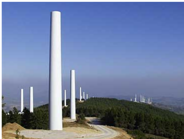
Σχήμα 4.7β: Πύργοι Α/Γ σωληνωτού τύπου, σε Αιολικό Πάρκο στην Ισπανία.
