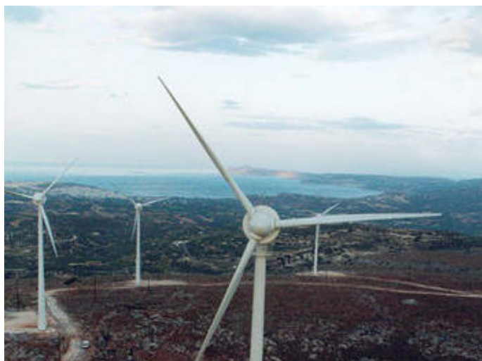
Αιολικό Πάρκο στη Σητεία ισχύος 27,5MW
