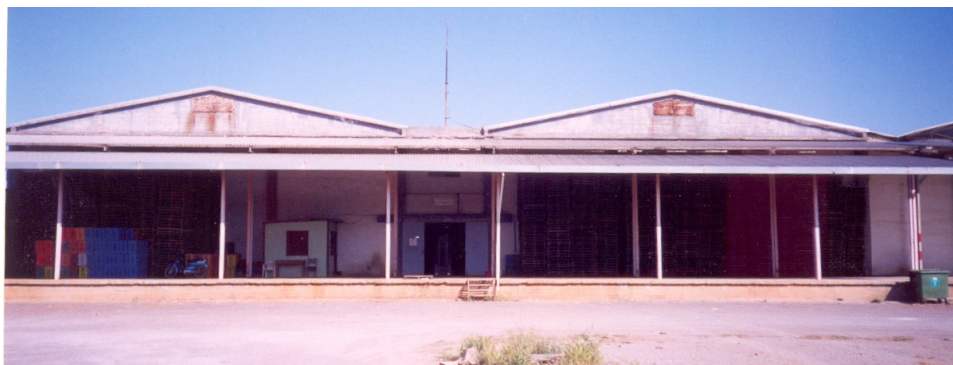
Εικόνα 5.33 Ψυγείο Ένωσης Αγροτικών Συνεταιρισμών Αρκαδίας στην Τεγέα
