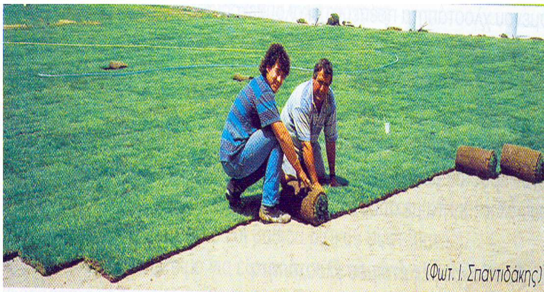
Εικόνα 10: Εγκατάσταση έτοιμου χλοοτάπητα (Ρέβελος)
