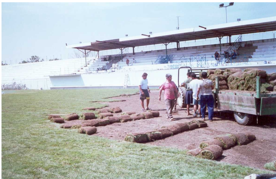
Εικόνα 13: Πανοραμική άποψη μισοτελειωμένου γηπέδου το οποίο στρώθηκε με τη βοήθεια μηχανημάτων (Ρέβελος)
