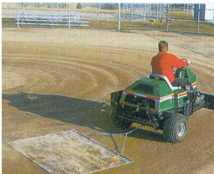
Εκόνα 8: Ισοπέδωση μίγματος εδάφους
