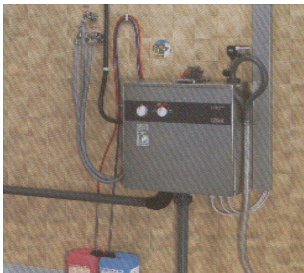
Σχήμα 3.4. Υπεραυτόματο σύστημα καθαριότητας αρμεκτηρίων.
