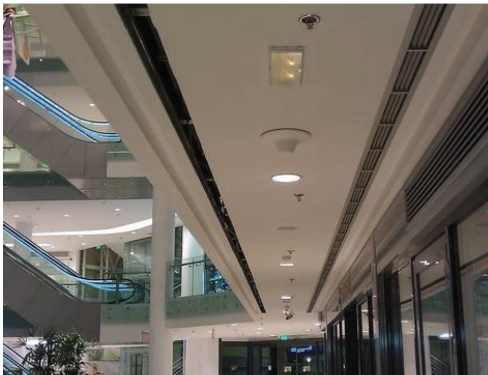
Εικόνα 4.15: Omni κεραία στηριζόμενη από ψευδοροφή
