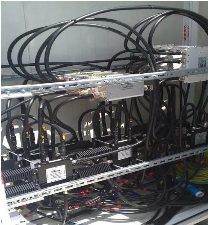
Εικόνα 4.14: Συνδεσμολογία παθητικών στοιχείων.
