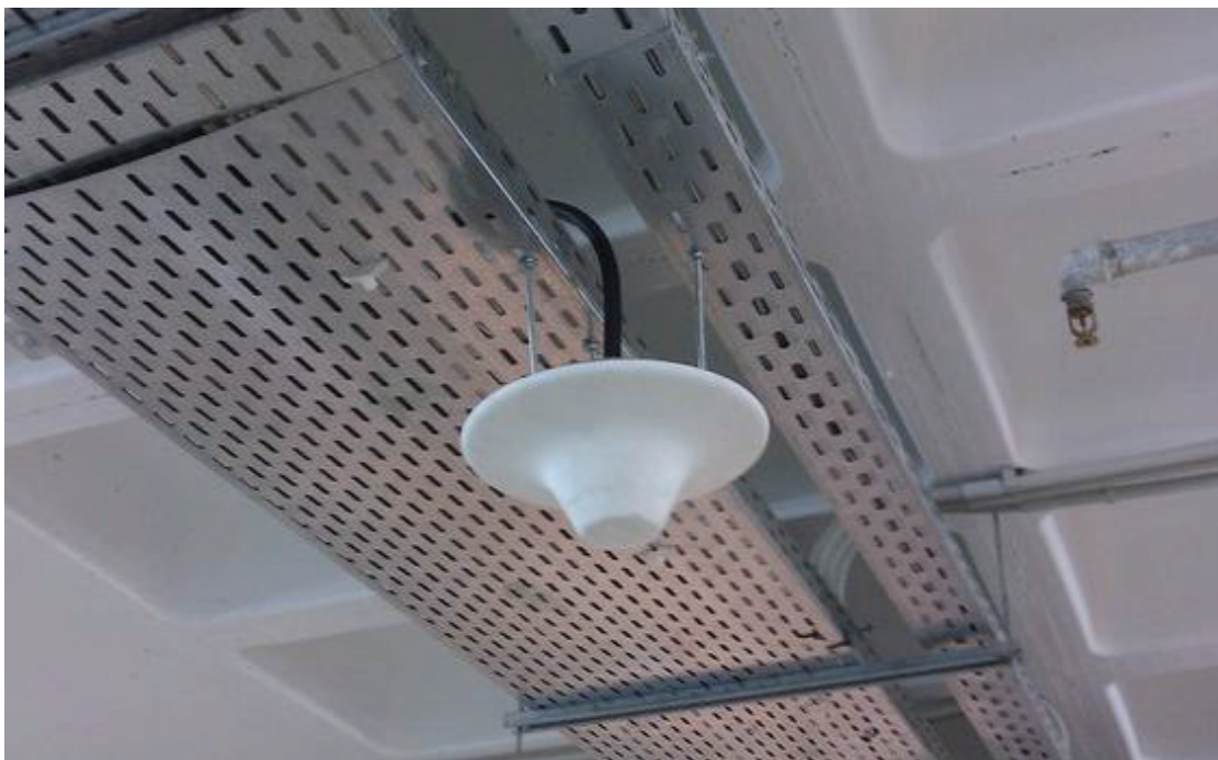
Εικόνα 4.17: Ομπι κεραία στηριζόμενη με ντίζα από υφιστάμενη ηλεκτρολογική σχάρα
