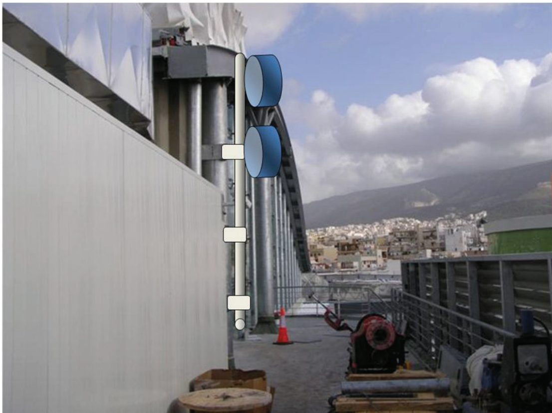
Εικόνα 4.2: Θέση εγκατάστασης κατόπτρων.
