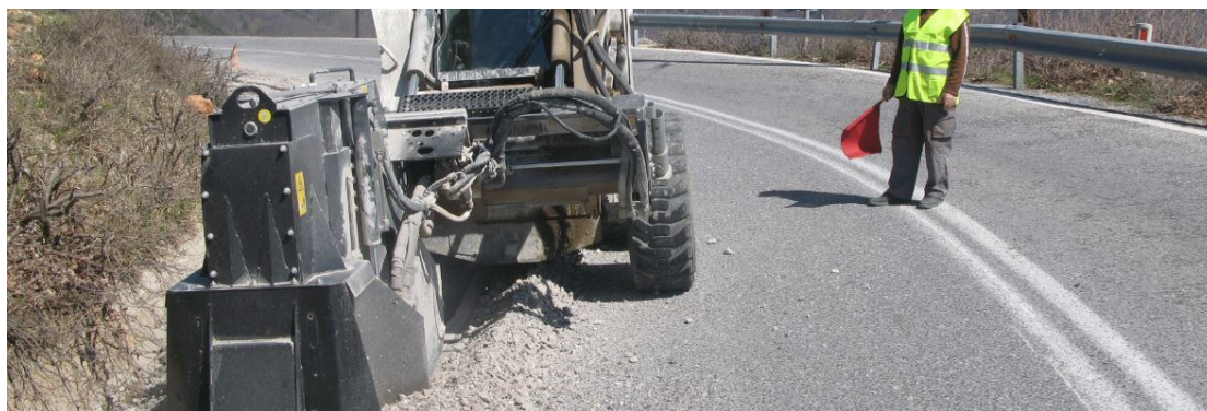
Σχήμα 2.1.3 Μέθοδος micro – trencher
