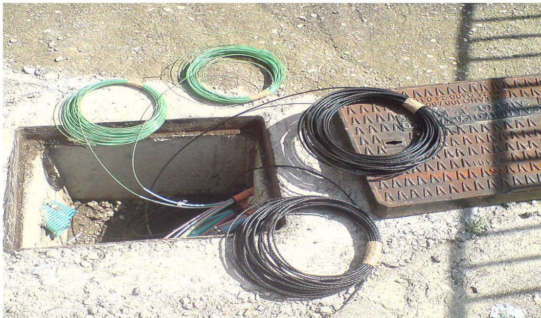
Σχήμα 2.1.4 Φρεάτιο οπτικών ινών
