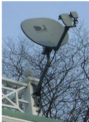
Figure 22 Εφαρμογή LNB σε δορυφορικό πιάτο
