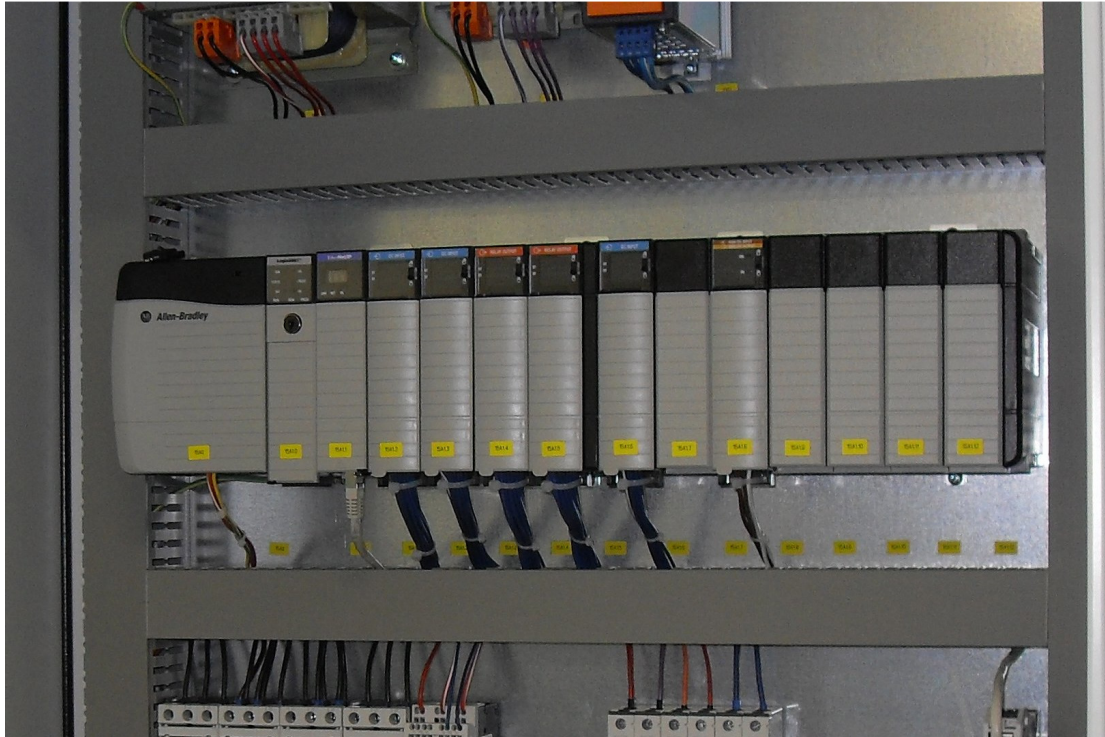
Εικόνα 5 - Πίνακας PLC
