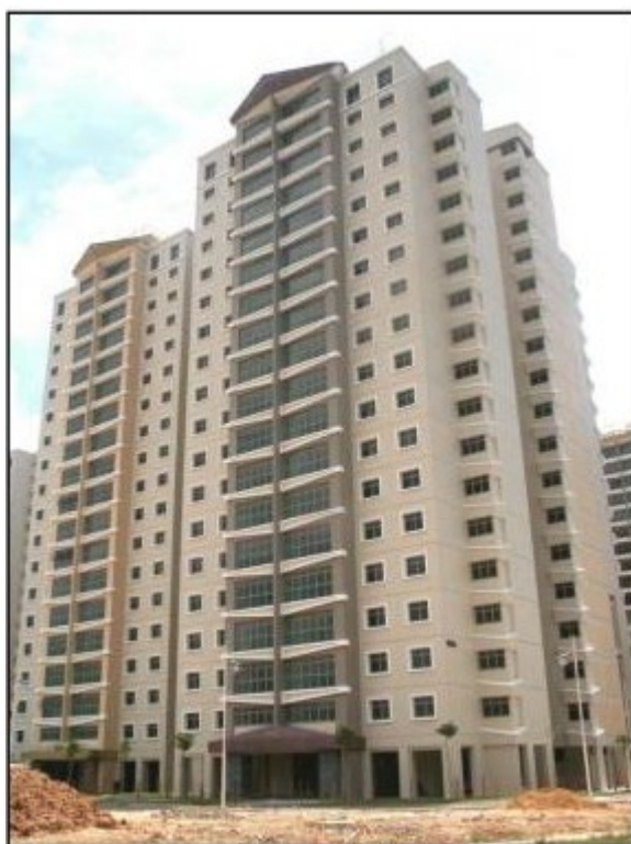
Εικόνα 3.1: Συγκρότημα κτιρίων στην Σιγκαπούρη με εγκατεστημένο σύστημα SHM.
