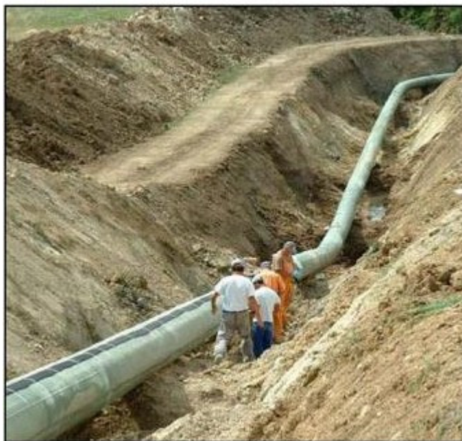
Εικόνα 3.4: Τοποθέτηση SMARTape στον αγωγό φυσικού αερίου.
