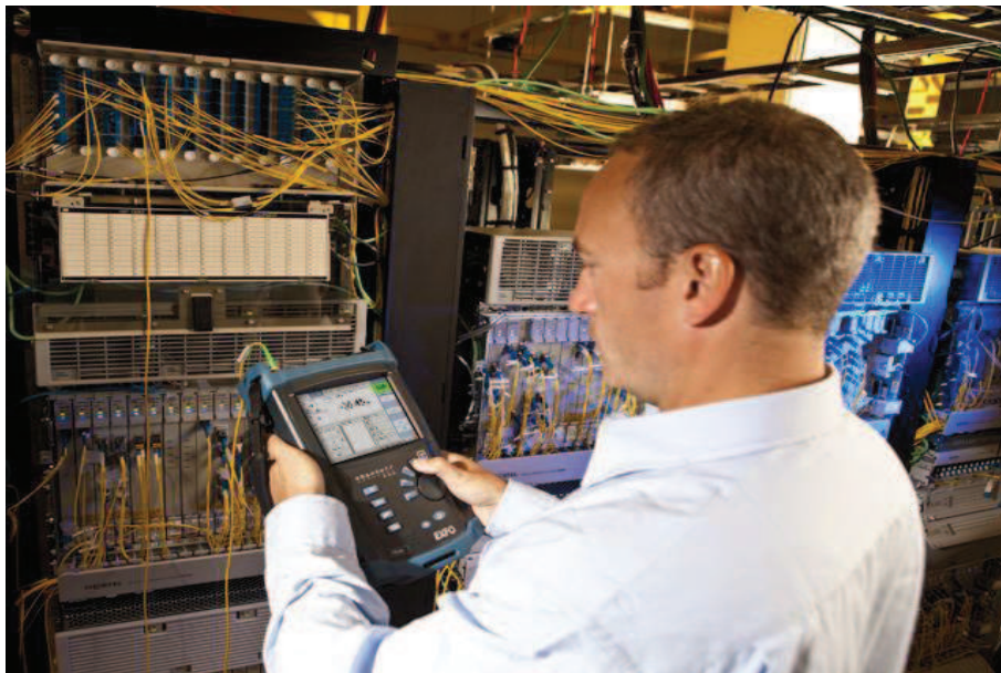
Σχήμα 31: Μέτρηση με OTDR
