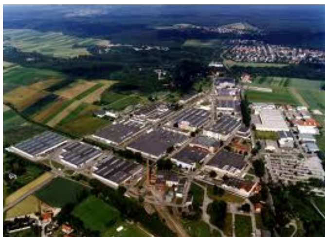
Εικόνα 1: Το βιομηχανικό πάρκο «Bobingen» κοντά στο Μόναχο, της Γερμανίας.
