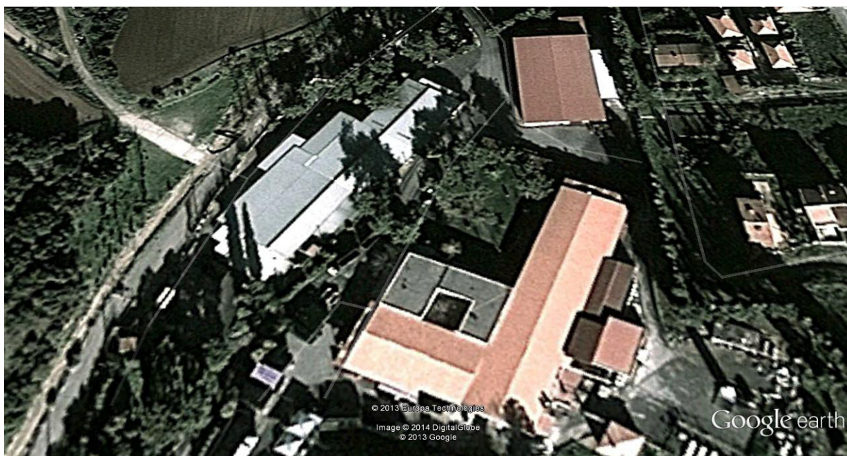
Εικόνα 1: Εργοστάσιο Σουρωτής. Πηγή: Google Earth.
